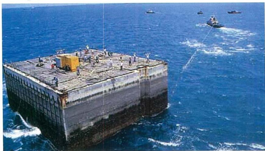
一般防波堤之沈箱拖放工程大多採「端進法」，即將製造完成的沈箱往外推進，然而為了爭取進度，除了使用「端進法」外，更創新使用「跳島式」施工法。「跳島式」安放沈箱是在已安放好之沈箱前，預留數座沈箱位置，先安放另一座序位較高的沈箱，使成為一個「島」，如此即可由此一沈箱「島」前後兩端展開施工，這種施工法的優點是由單向施工發展擴大為三向施工，增進安放速度。
